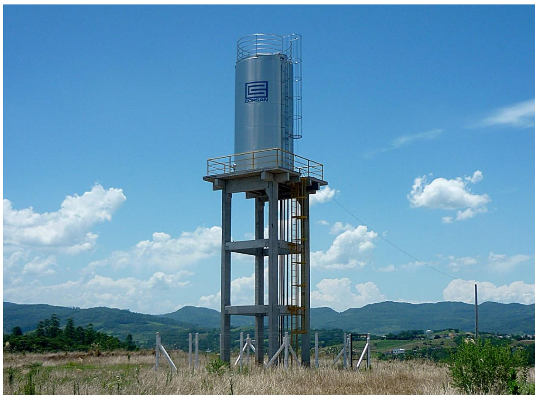
Figura 1 - Modelo de reservatório de água elevado, em aço inox, padrão Corsan.
