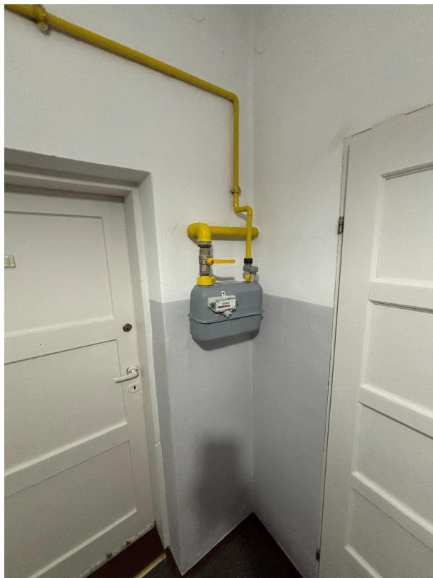
Rysunek 3 Instalacja do demontażu i odcięcia
