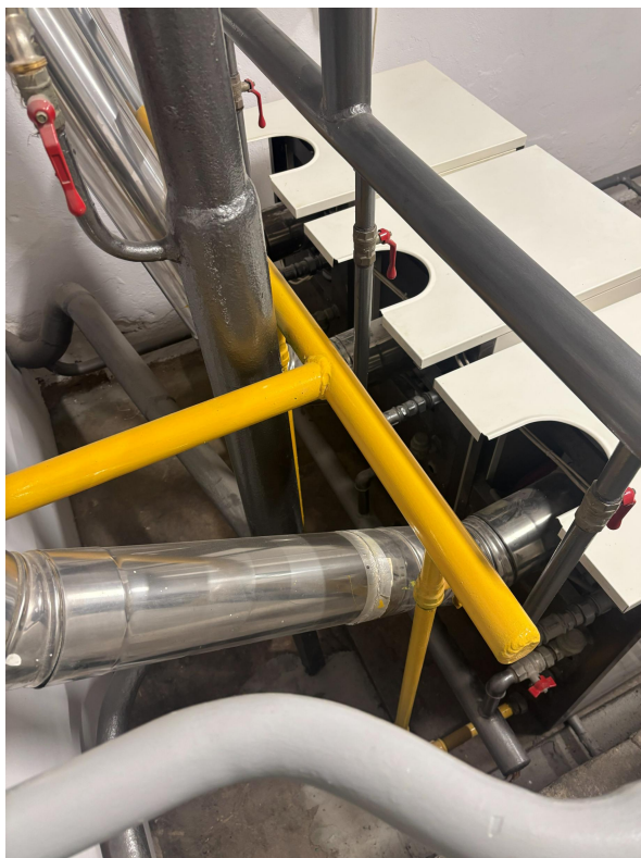
Rysunek 2Podłączenia kotłów
