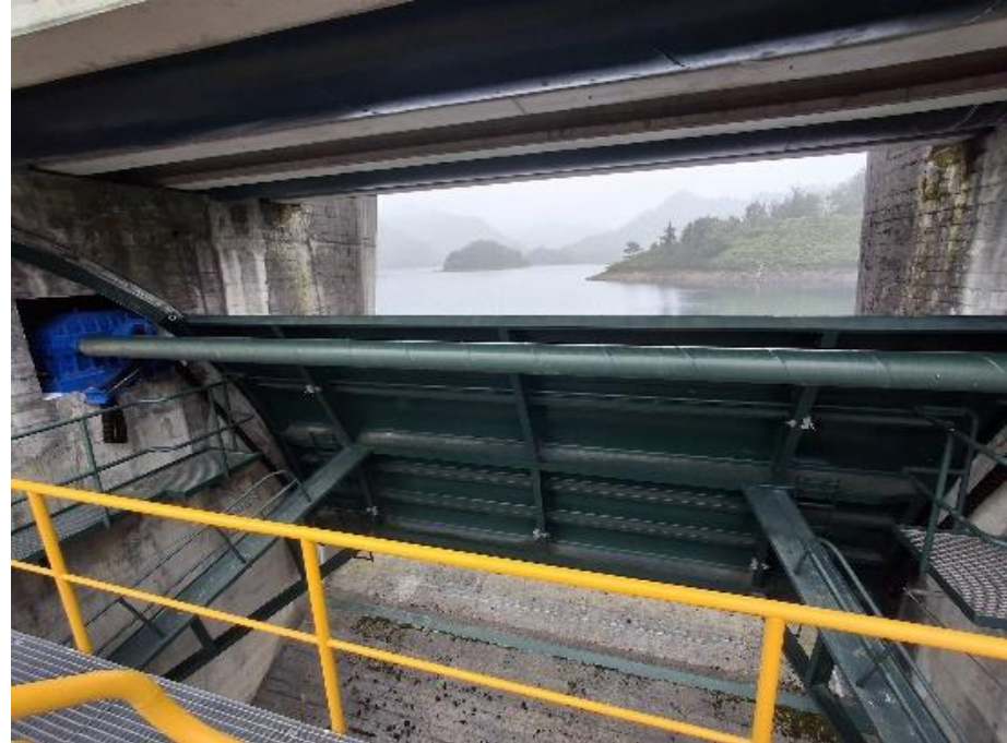
Vista general en posición para rehabilitación
